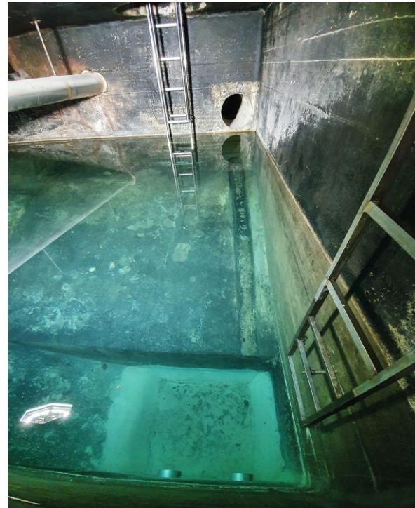
Rechts: Wassersammelbecken des Abwasserpumpwerkes Burg, hier zur Dichtheitsprüfung noch mit Trinkwasser gefüllt.
