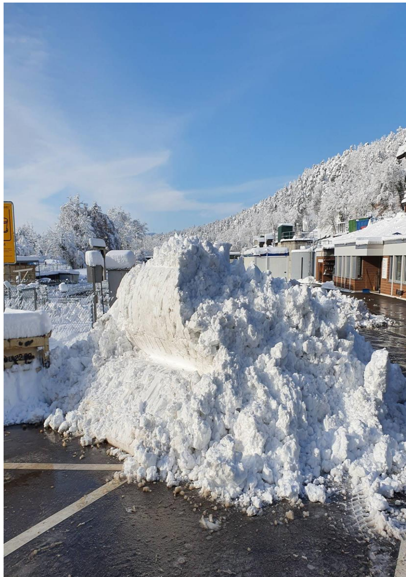
Januar 2021: Die Kläranlage versinkt im Schnee
