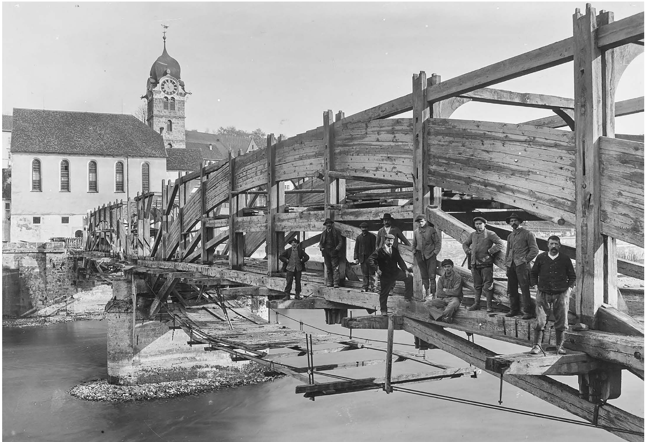
Abbruch der gedeckten Holzbrücke beim Rheinstau 1919 (Museumsbestand)
